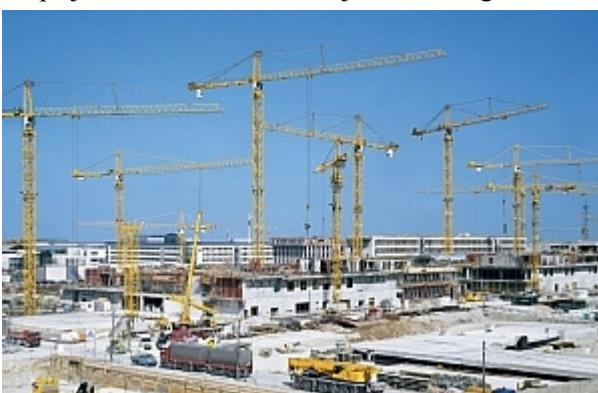
konstrukcija. Sastoje se od okretnog i po potrebi na tračnicama pokretnog tornja na kojem se nalazi krak (grana, strijela) s opremom za dizanje tereta pomoću užadi. Krak može biti *vodoravna grana* (po njemu putuje oprema za dizanje) ili *kosa strijela* okretna u uspravnom smislu (oprema za dizanje ima hvatište na kraju kraka). Prevladavaju uglavnom *toranske dizalice s vodoravnim granom* (slika lijevo←).
