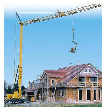
prijenosne, uglavnom velike (potrebno je rastavljanje prilikom premještanja), te polupokretne ili samohodne samosastavljuće manje toranske dizalice (slika desno→). Toranske dizalice na kamionskom podvozju jesu **toranske autodizalice**. →detaljnije vidi
